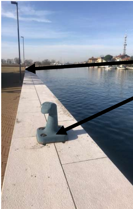
Fig 30 b : Particolare delle “Bitte” di attracco
