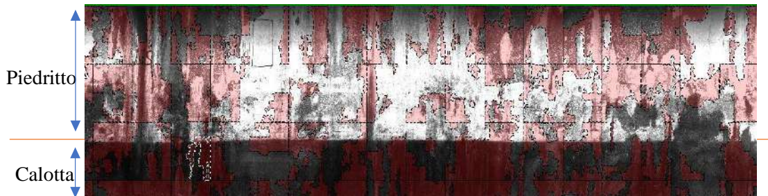
Figura 4-32: Digitalizzazione di una porzione del piedritto destro della galleria in esame (Threshold=90, Blur size=3).
